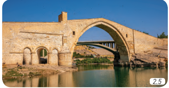
Malabadi Köprüsü- Diyarbakır
